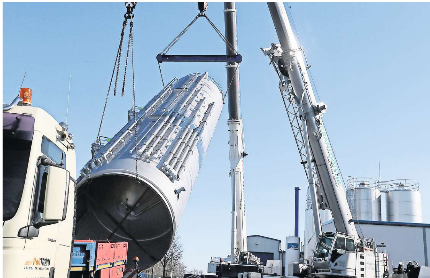
Ein Behälter des neuen Dreifach-Tanks für die Kohrener Landmolkerei wird vom Tieflader gehoben und aufgestellt.
