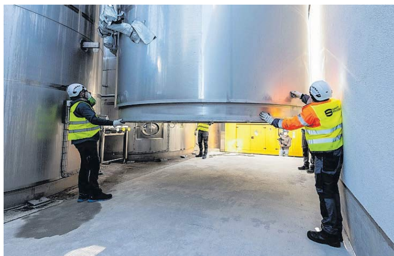
Präzise wurde der neue Großtank in das Gebäude der Kohrener Landmolkerei jongliert.
