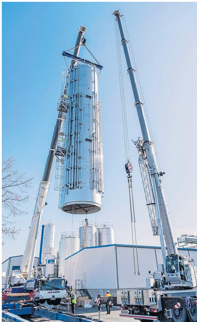
Die Kohrener Landmolkerei in Penig hat ihre Tankkapazitäten erweitert und fünf neue Großtanks aufgestellt. Damit können nun 260.000 Liter Milch zusätzlich gelagert werden.
