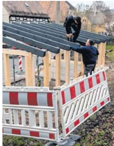
Handwerker bauen für das Bushäuschen die Holzkonstruktion auf.
